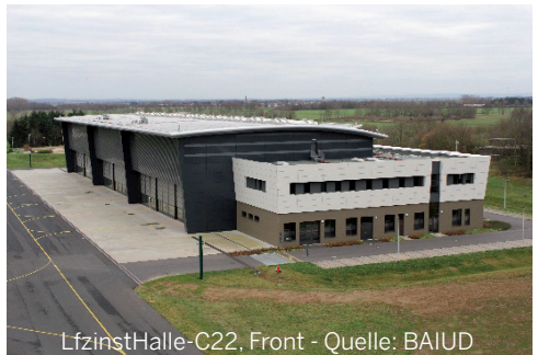
LfzinstHalle-C22, Front - Quelle: BAIUD
